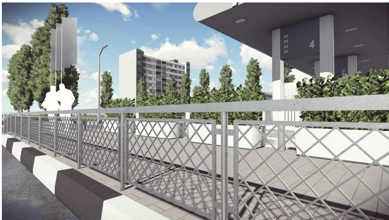
Ограждение пешеходной зоны от проезжей части
