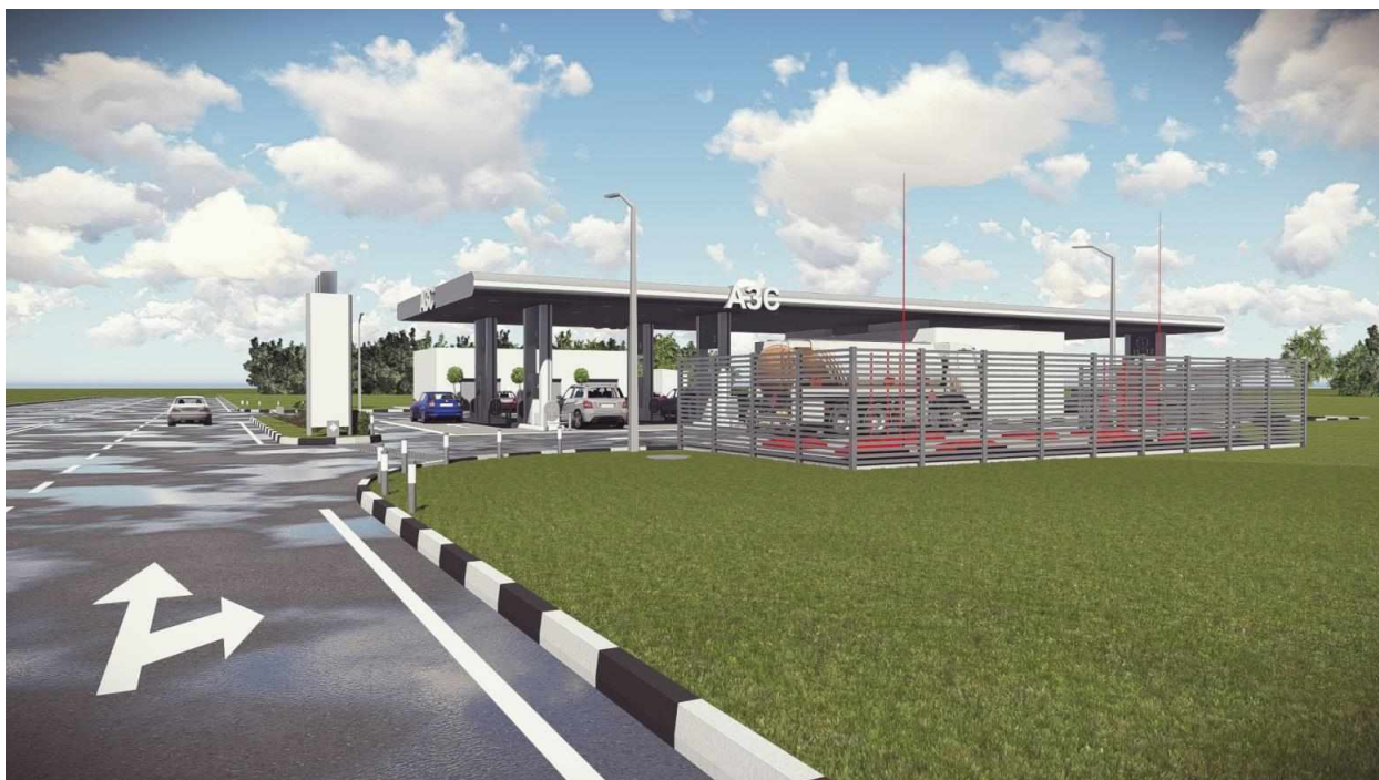
Ограждение мусорных контейнеров и контейнеров хранения топлива
